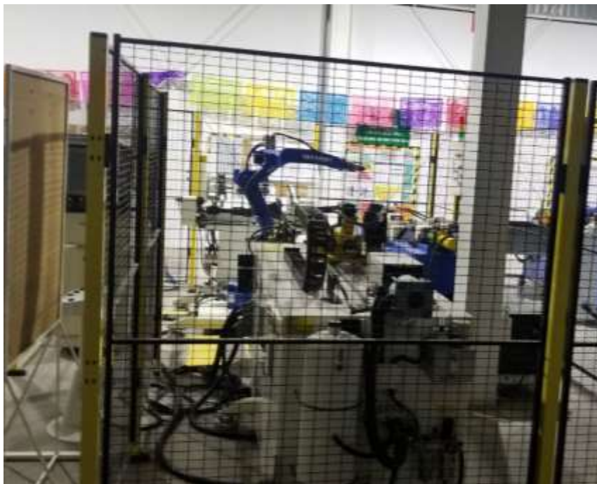
Figura 15 Maquinaria de la dobladora dos. Fuente: AMINSA Acabados Metálicos Innovadores S.A De C.V., 2022.
